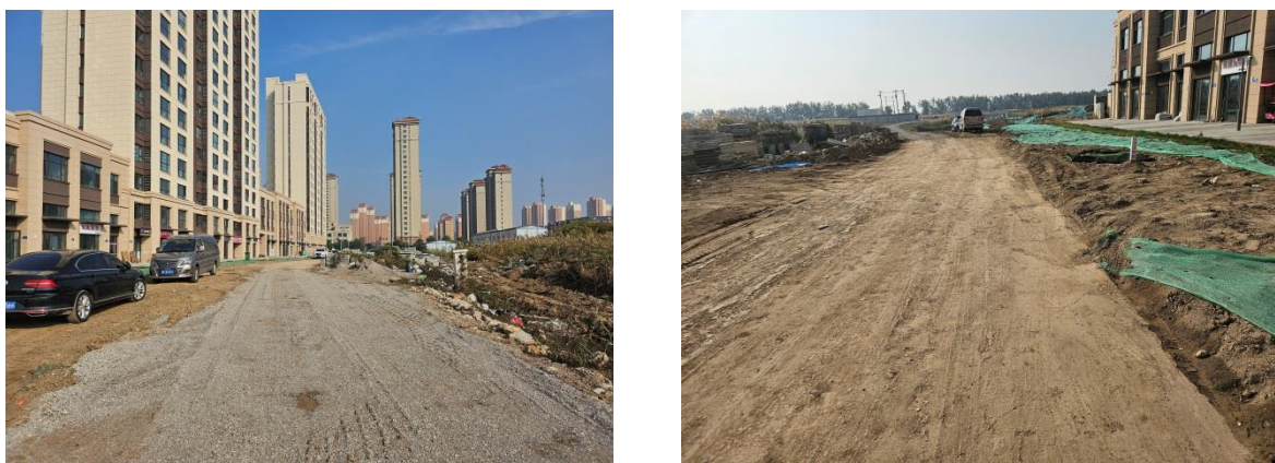
图 2-6 项目现场照片
